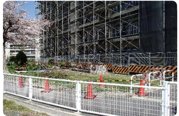
施工中の外装改修工事
