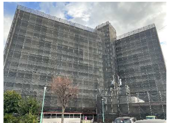
令和7年度に外装工事を実施中の市営外新荘
