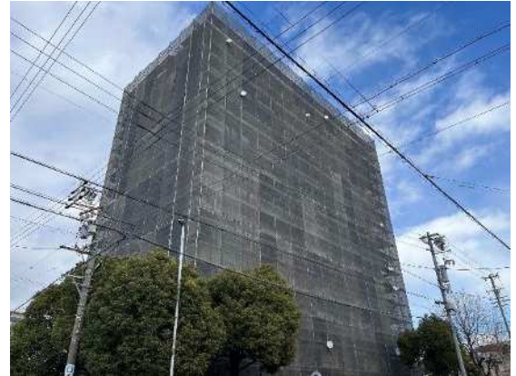
令和7年度に外装工事を実施した市営外新荘
