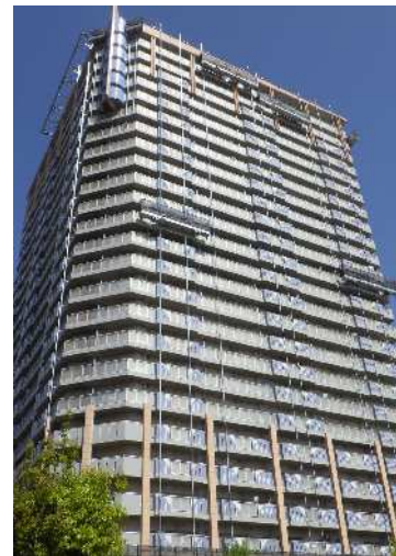
令和4年度から外壁改修施工中の市営みなと荘
