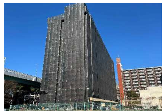
外壁改修の施工状況(令和5年度)
