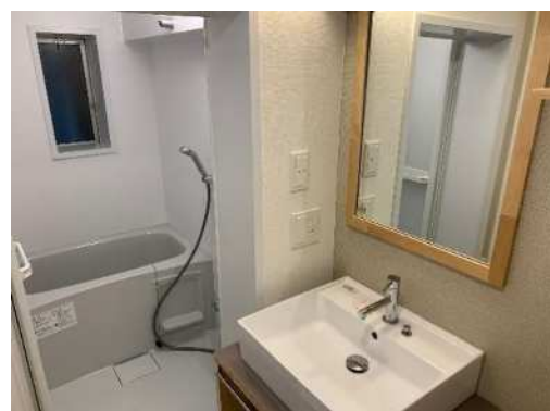
・浴室、洗面台等を改修
