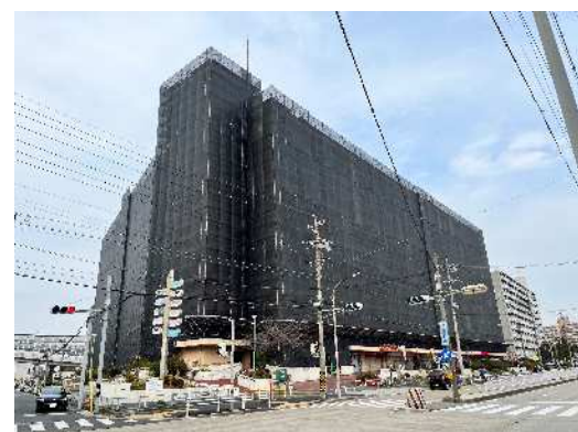
外壁改修の施工状況(令和4年度)
