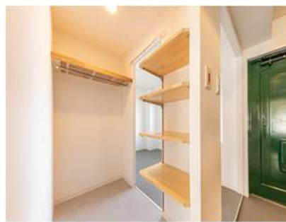
・玄関横の室内を土間に改修
