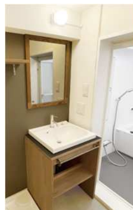
・洗面台等を改修
