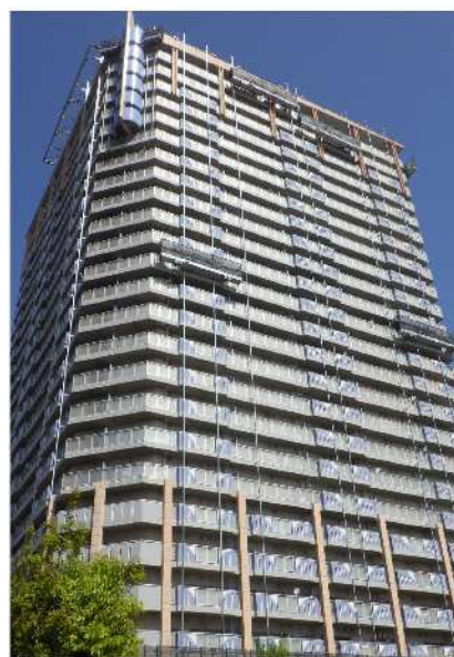
令和4年度から外装工事に着手した 市営みなと荘1棟
