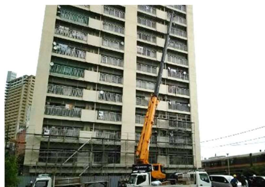
施工中の外壁改修施工(令和2年度)
