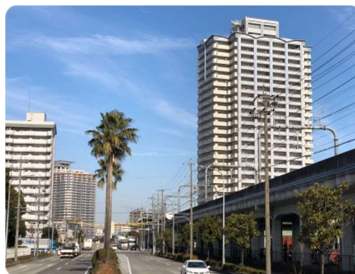
令和2年度に外壁改修を実施した超高層住宅「シティファミリー鴨浦」(右)
