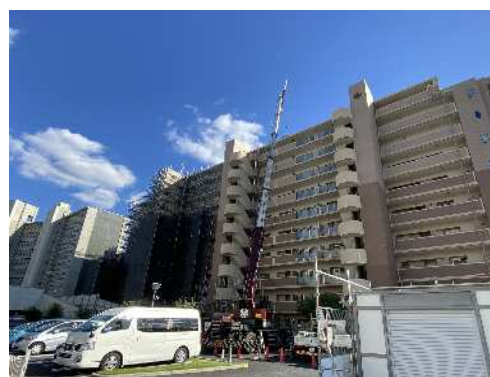
令和3年度にマンション管理組合から工事監理を受託したシティコーポリフレ黒川
