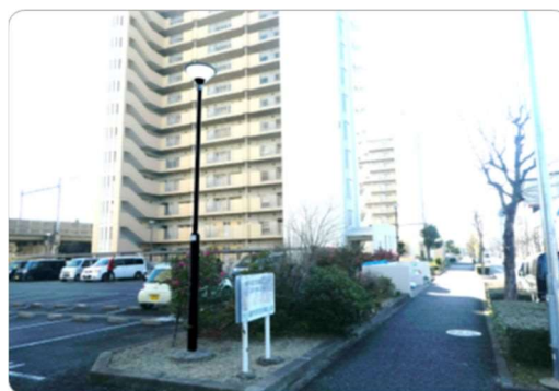
住宅敷地内に設置されるすべての外灯(約5千基)について、28年度より5カ年の計画でLED化を実施
