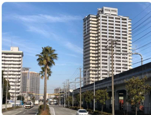
実施設計を終え、2年度に外装改修を予定する超高層住宅「シティファミリー鴨浦」(右)
