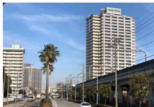
令和2年度に外装工事を実施した シティファミリー鴨浦(右)
